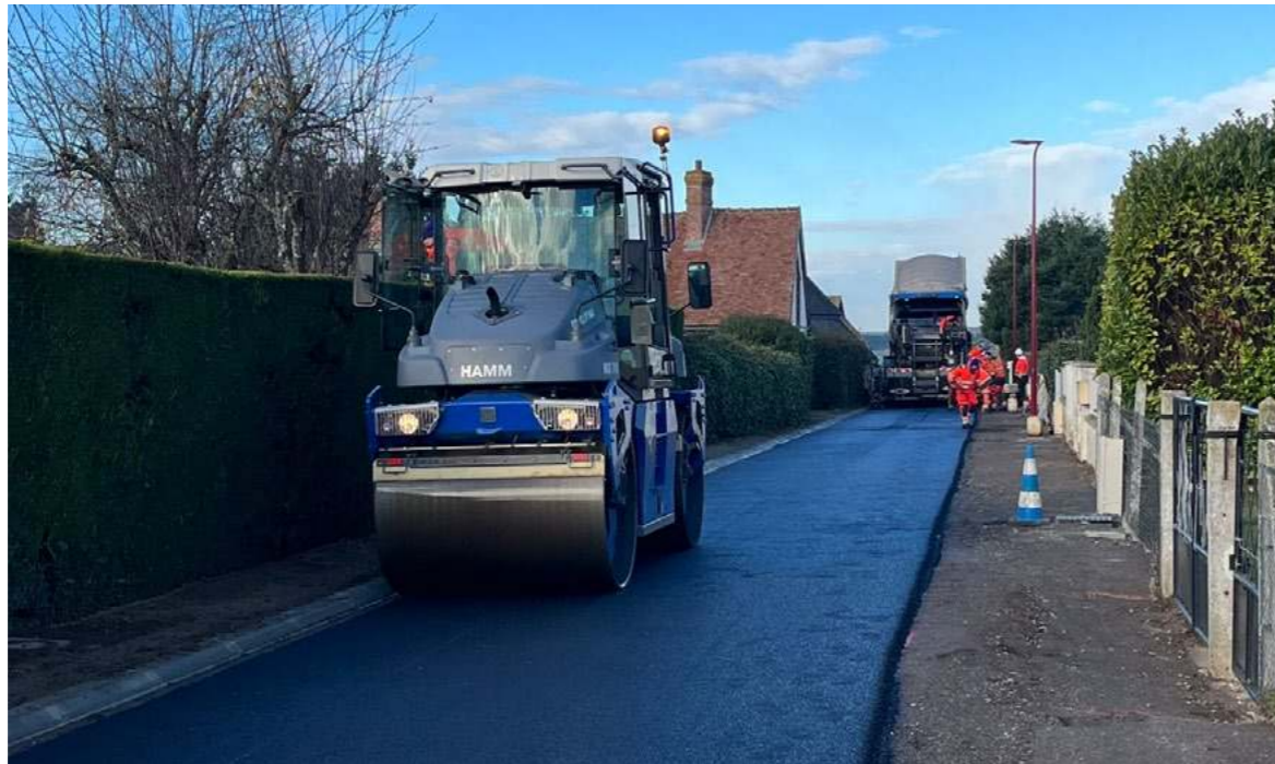
Travaux de voirie à Breteuil
