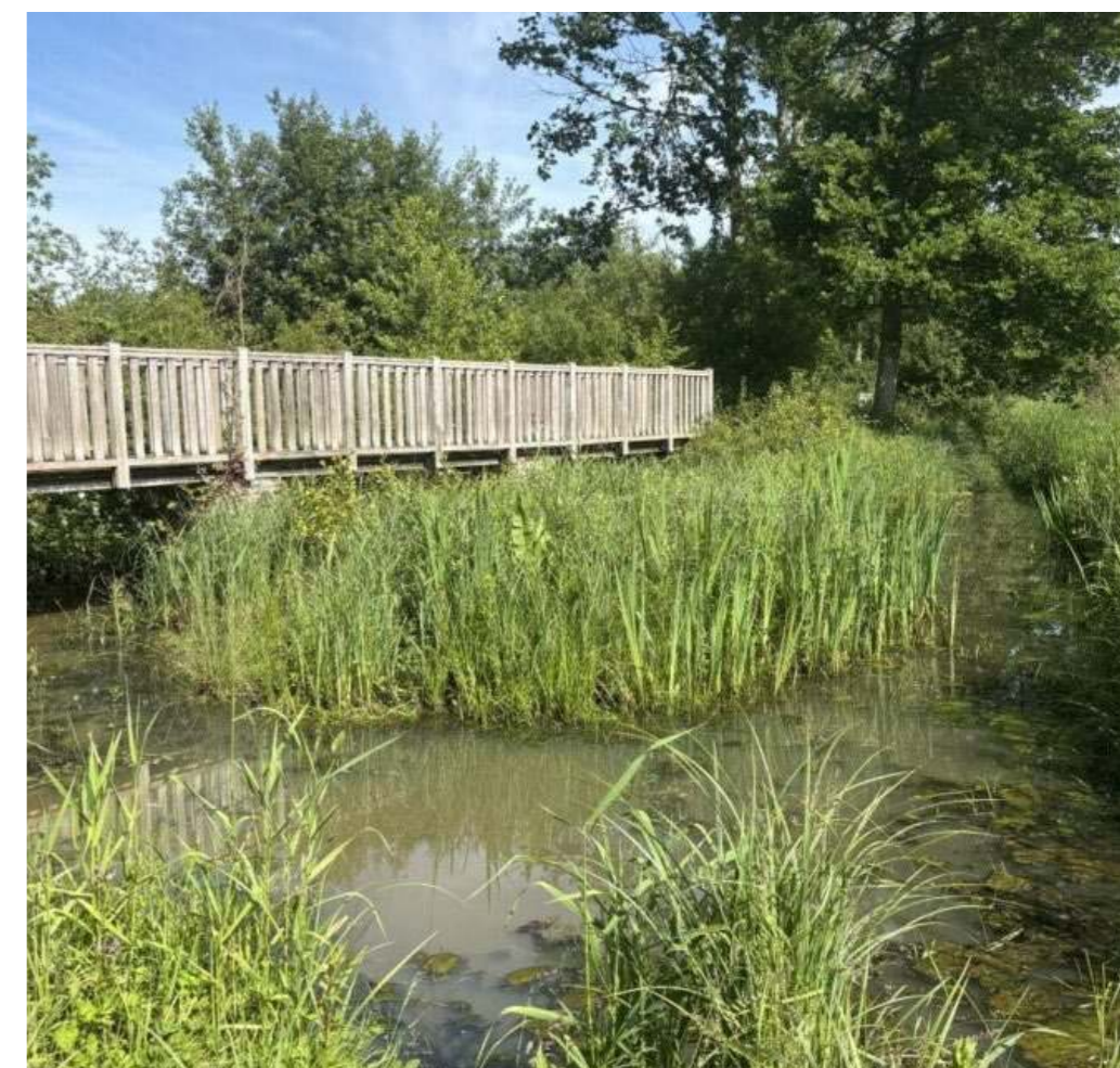
Création d'aménagements à Sainte Marie-d'Attez
