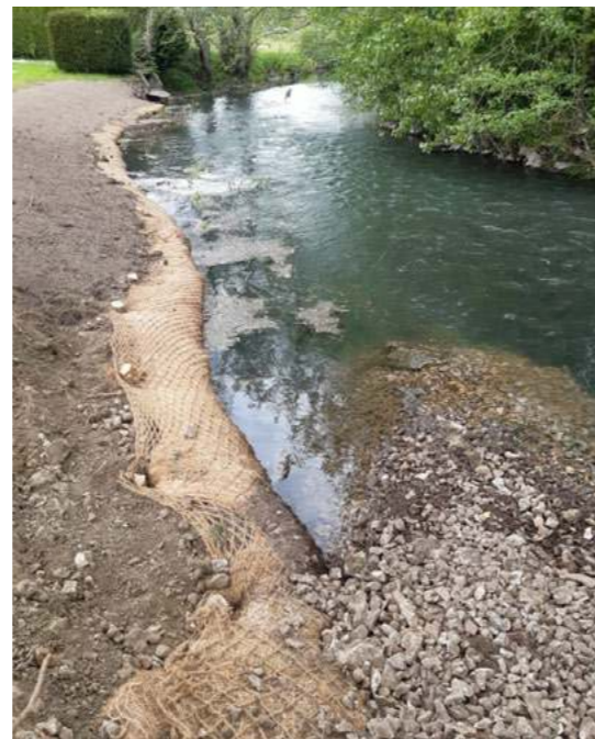
Restauration de berges à La Vieille-Lyre
