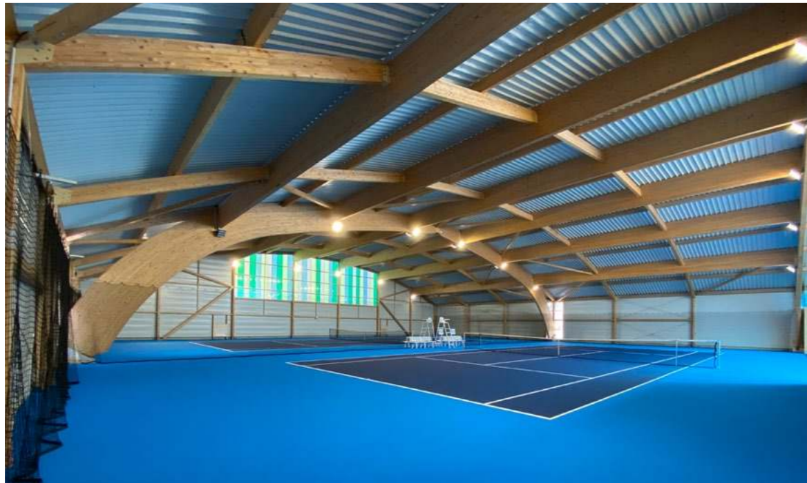
Nouveaux terrains de tennis couverts à Mesnil-sur-Iton
