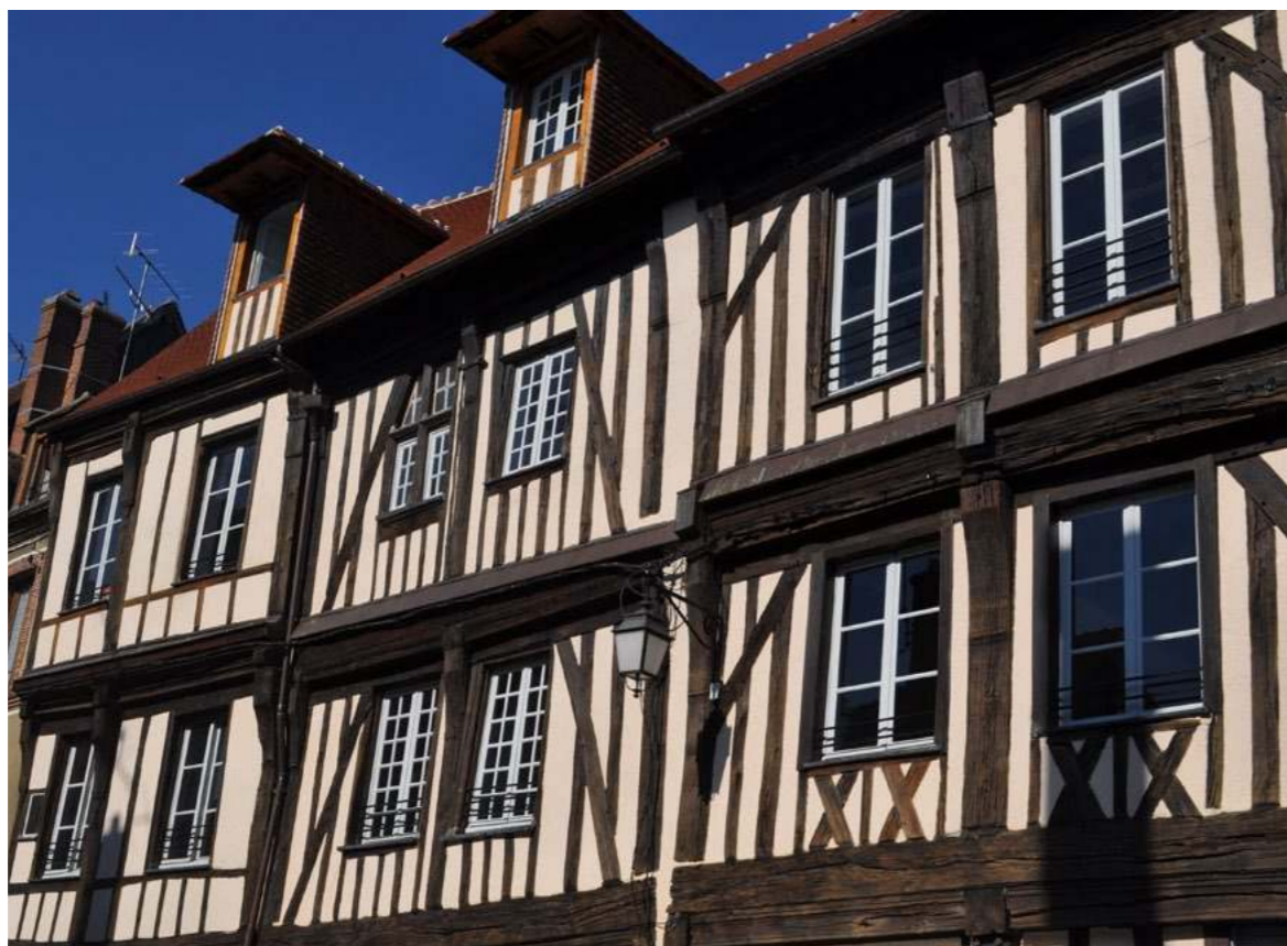
Maisons à pan de bois en centre-ville de Verneuil
