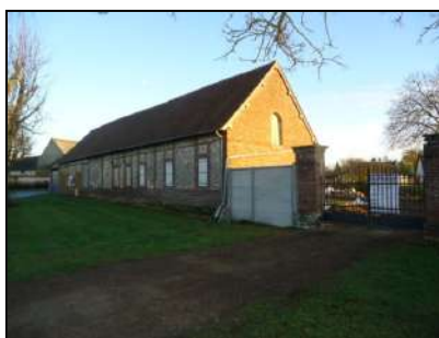
Maison traditionnelle allongée avec soubassement et murs latéraux en briques apparentes au sein d'un corps de ferme
