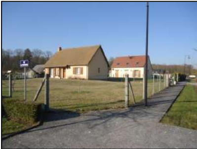
Pavillon traditionnel dans le lotissement du Bois des Forges
