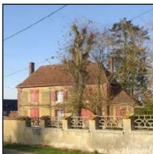
Maison à étage ancienne en maçonnerie enduite et chaînage en briques le long de la rue des Chênes
