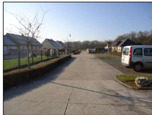
Places de stationnements au lotissement du Bois des Forges en accompagnement des nouveaux logements
