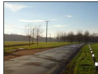
RD 32 – rue des Chênes à la sortie Est du bourg
