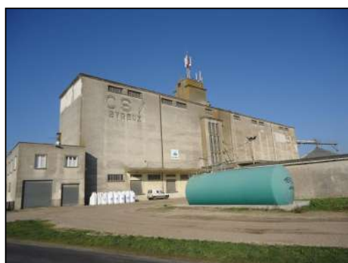
Silo de stockage de la coopérative NatUp en bordure de la D32.
