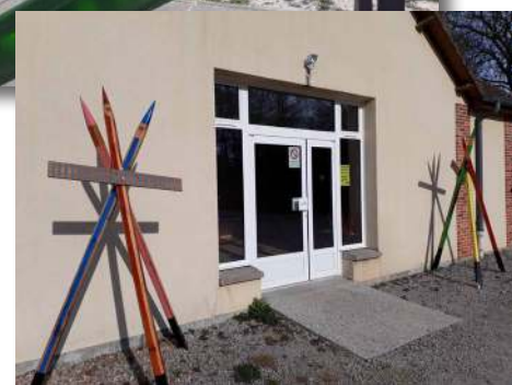
Rénovation du groupe scolaire de Chennebrun
