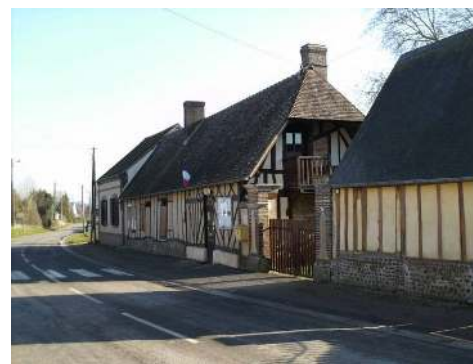
Réhabilitation de l'ancienne mairie de Guernanville en 2 logements locatifs par la commune du Lesme
